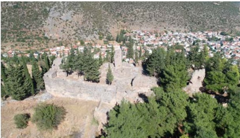
Εικ. 42 Αποψη του ακροπυργίου του Κάστρου της Άμφισσας. Το ακροπύργιο αποτελούσε το ύστατο σημείο άμυνας σε περίπτωση πολιορκίας. Σε αυτό το τμήμα διακρίνονται οι διαδοχικές οικοδομικές φάσεις από την αρχαιότητα μέχρι τη σύγχρονη εποχή.
